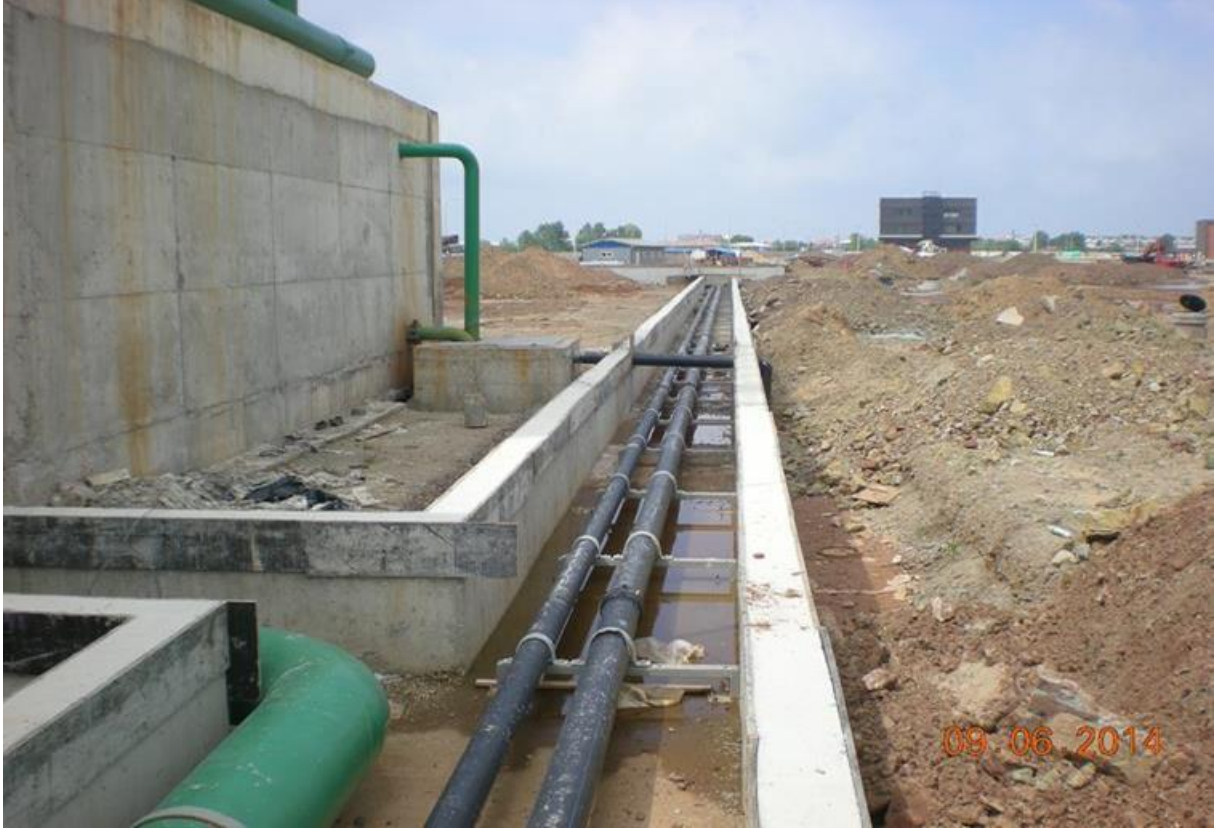
Tesis İi ve Tesisler Arası Borulama İŐi
