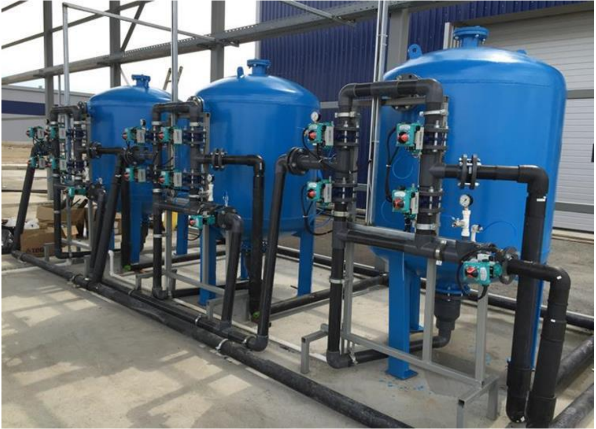
Kum Filtreleri Boru Bağlantı İşi
