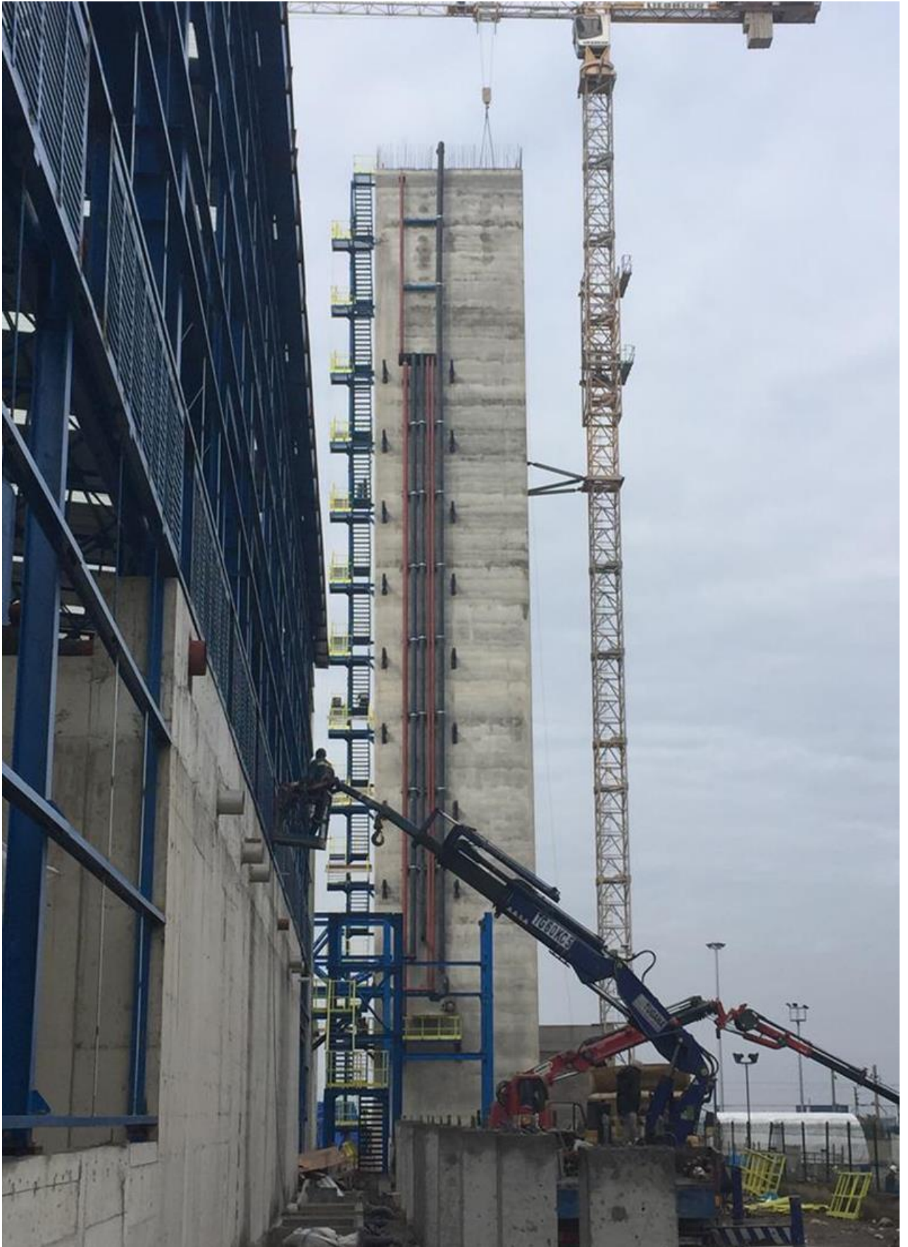
Yangın Söndürme ve Su Depoları Borulama İşi
