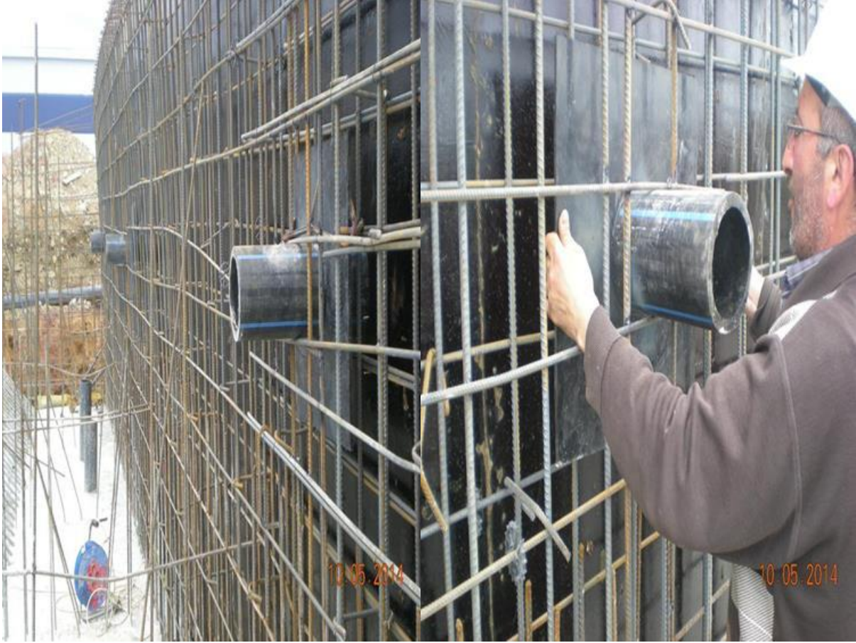
Betonarme Yapılara Gömülü Eleman İmalatı İşi
