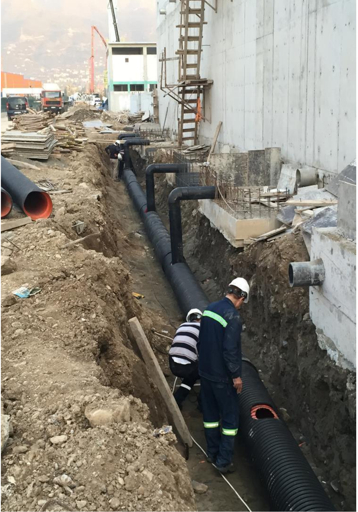
Drenaj Hatları Borulama İŖi
