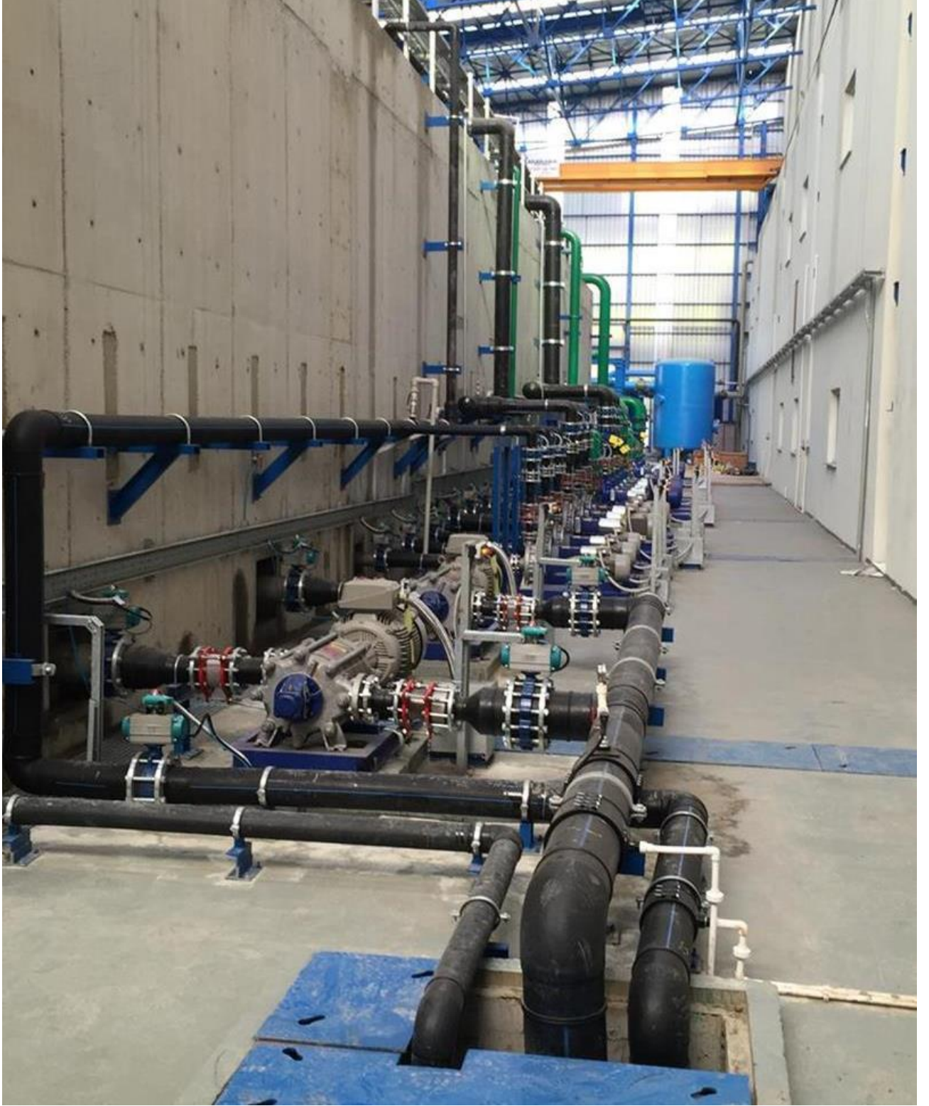
Pompa İstasyonu Borulama İşİ
