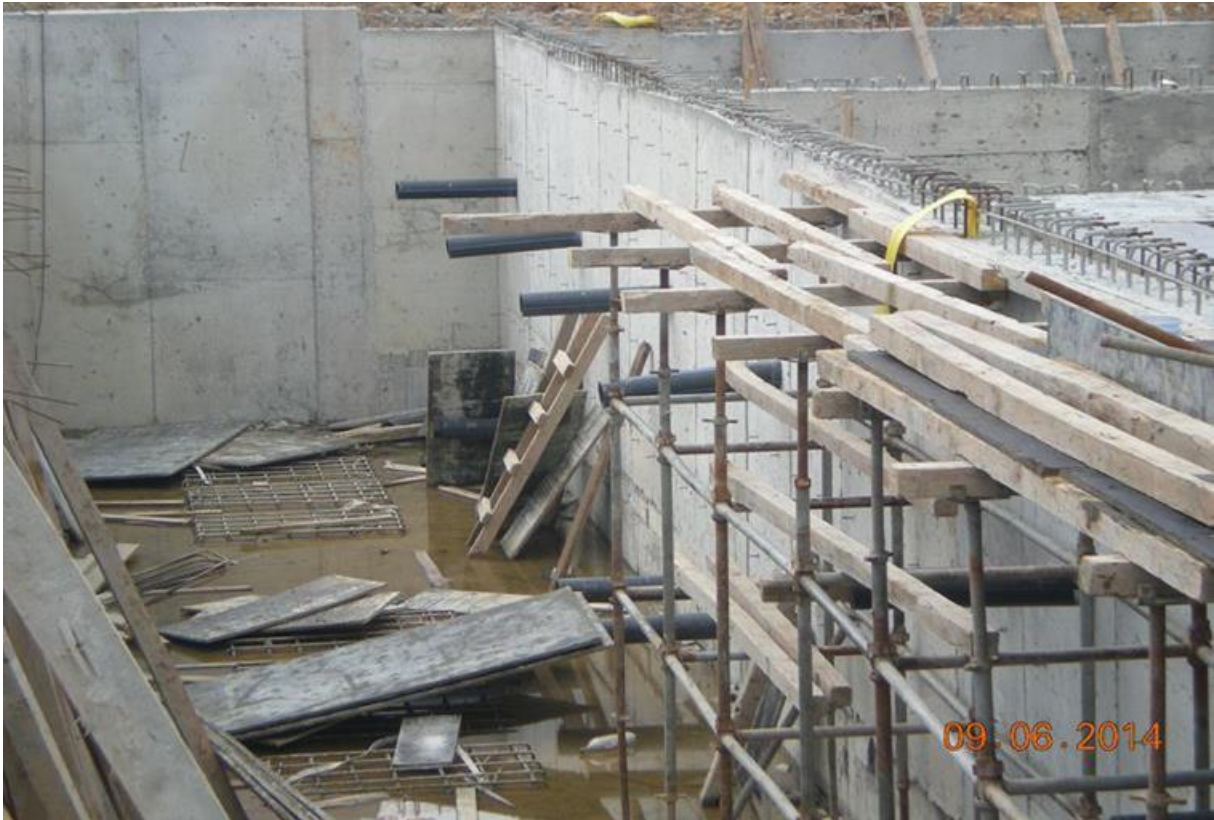
Betonarme Yapılara Gömülü Eleman İmalatı İşi
