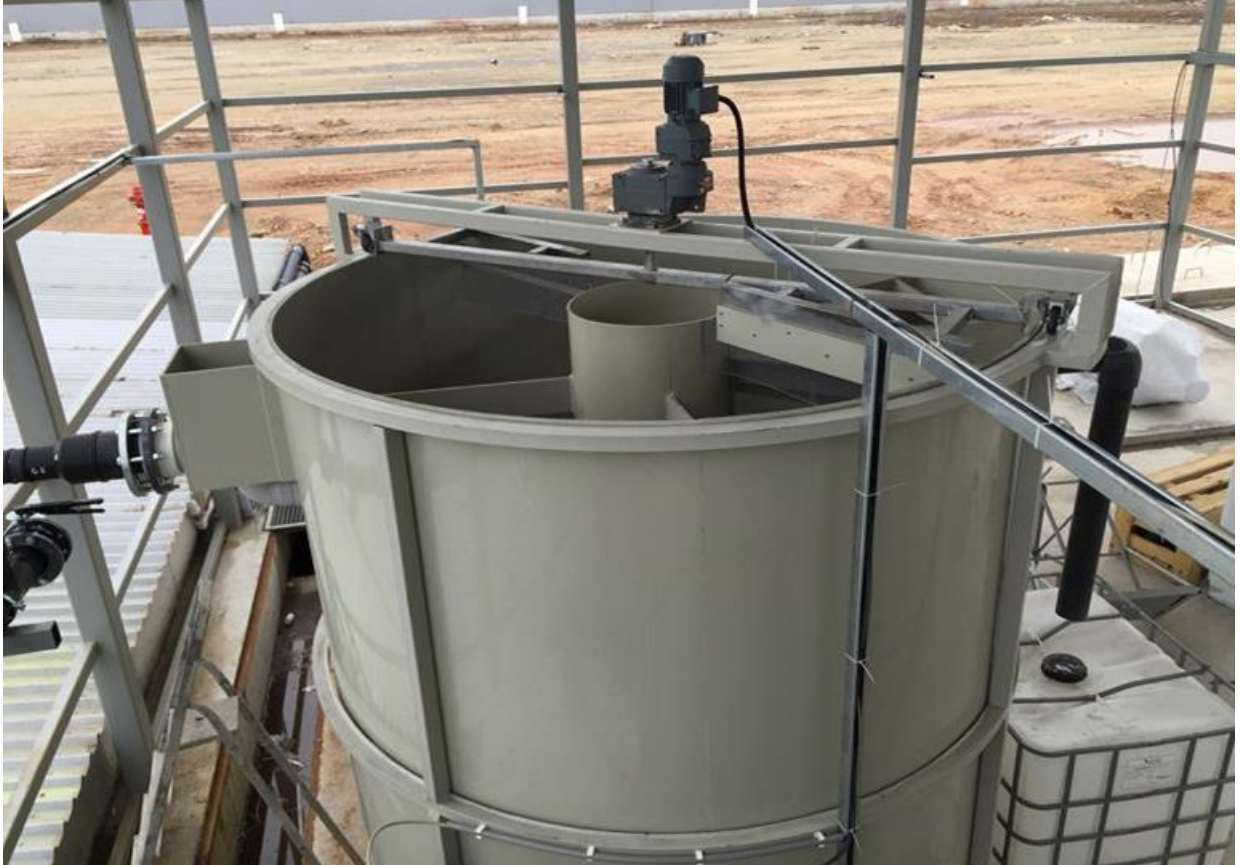
PE 100 Asit ,Kostik, DAF Sistemi Tankları
