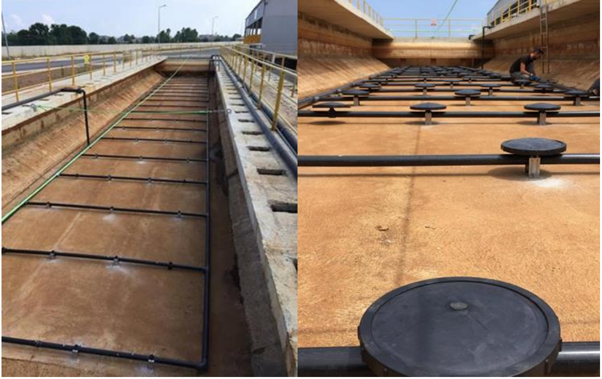
Biyolojik Arıtma Difüzör Borulama ve Bağlantı İşi
