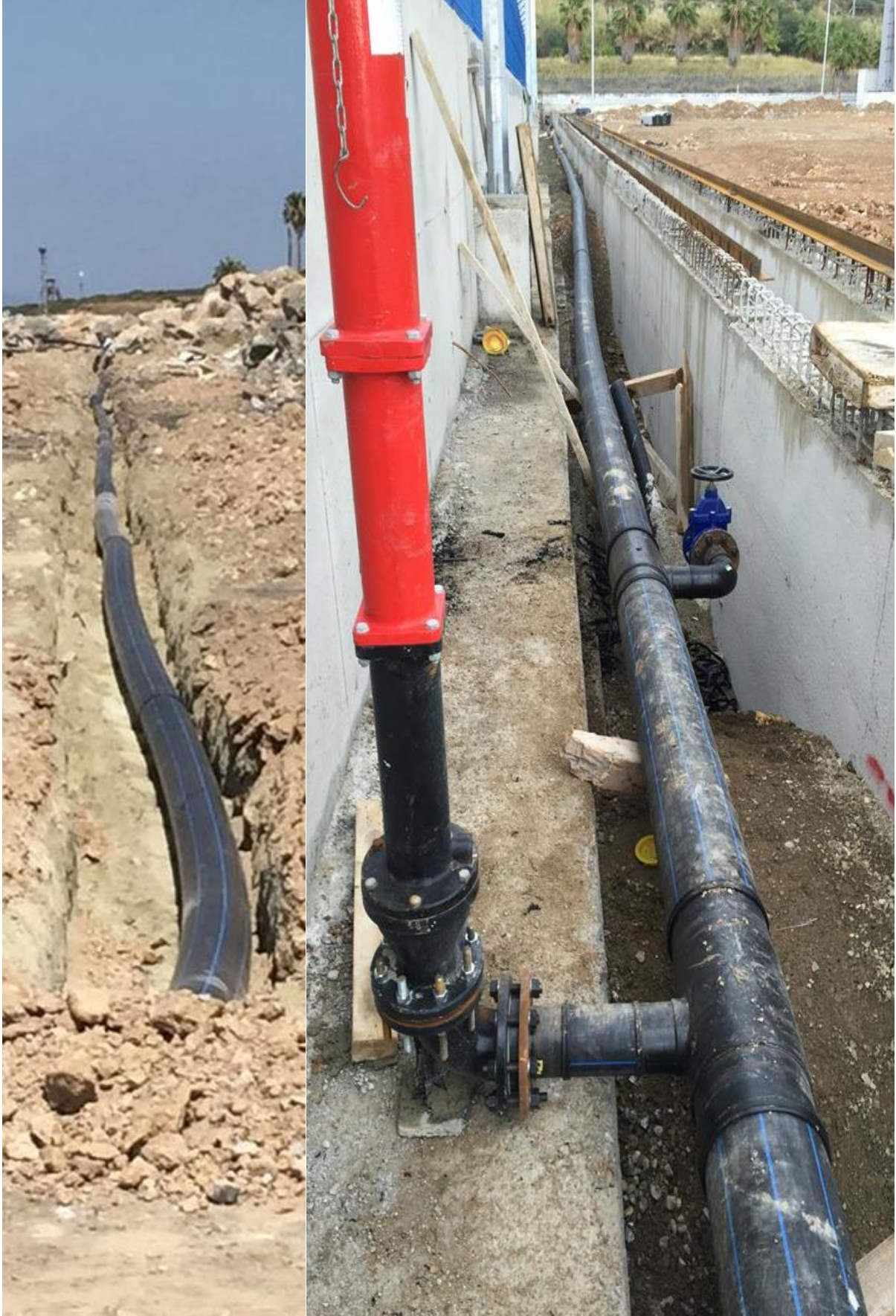
Liman ve Tesis İi Yangın Söndürme Hatları Borulama İŖi
